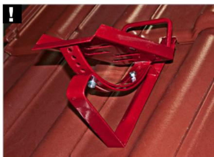
Montaż stopnia kominiarskiego mdm® należy przeprowadzić w analogiczny sposób. Stopnie kominiarskie przykręcamy bezpośrednio do wspornika (z pominięciem mocownika ławy kominiarskiej).
