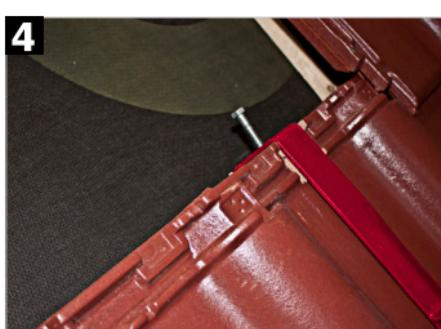
Kolejnym etapem jest przykręcenie jednczęściowego wspornika (typ D) do ląty (za pomocą wkrętów z łączem sześciokątnym). Profil górnego zaczepu jednczęściowego wspornika (typ D) umożliwia montaż bezpośredni na lącie podporującej dachówkę.
