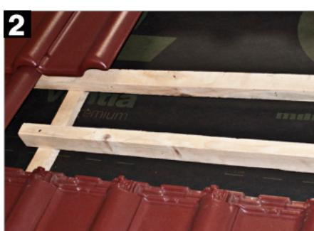
Do konstrukcji dachu należy przykręcić latę montażową (standardową lątę w miejscu dolnego podparcia wspornika). Wysokość zamontowania lat uzależniona jest od modelu dachówki.
