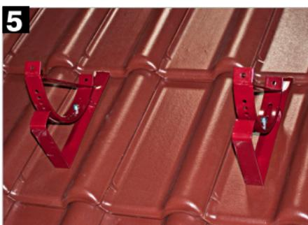
Po ułożeniu górnego rzędu dachówek należy uszczelić miejsca wyciętych zamków. Na wsporniku należy ułożyć i wypoziomować mocownik ławy kominiarskiej. Oba elementy należy ze sobą skręcić za pomocą załączonych do zestawu śrub.
