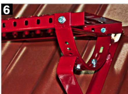
Po zamocowaniu drugiego wspornika z mocownikiem (za pomocą załączonych śrub) należy przykręcić ławę kominiarską. Następnie należy sprawdzić poprawność wykonanego montażu, w szczególności należy sprawdzić stabilność wszystkich połączeń mechanicznych.
