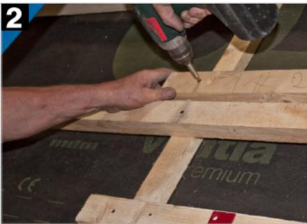
Do konstrukcji dachu należy przykręcić dwie łaty montażowe (w miejscu przymocowania wspornika oraz łatę w miejscu dolnego podparcia wspornika). Wysokość zamontowania łaty uzależniona jest od modelu dachówki.
