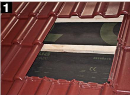
Prace należy rozpocząć od demontażu części dachówek – występujących w miejscu planowanego umieszczenia komunikacji dachowej.
