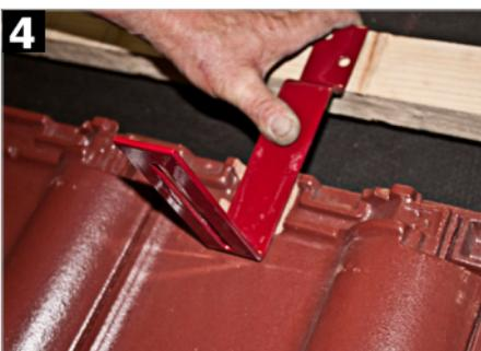
Kolejnym etapem jest przykręcenie dolnego elementu dwuczęściowego wspornika (typ S) do wcześniej zamontowanych łat montażowych.
