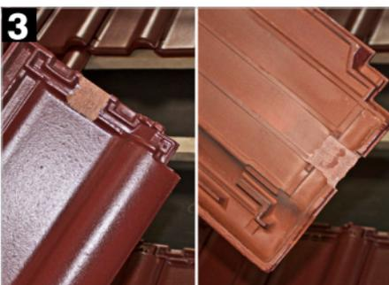
W dachówkach, które mają zostać ułożone bezpośrednio na zamocowanym wsporniku należy wyciąć kolidujące zamki.
